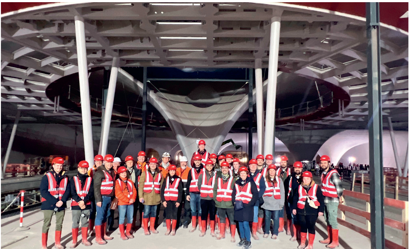
Abb. 10.1: Der Arbeitskreis Stuttgart bei seiner Exkursion zur Großbaustelle Stuttgart 21 am Stuttgarter Hauptbahnhof
