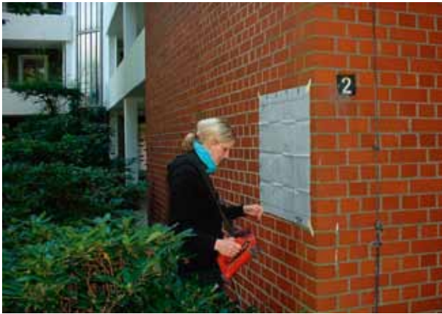
Abbildung 9: Einsatz des induktiven Messgeräts auf dem Messfeld (600x600 mm) auf der Fassade mit aufgeklebtem Messraster
