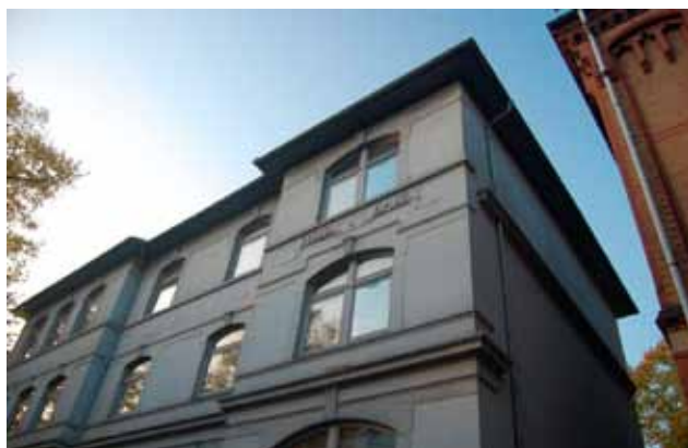
Abbildung 1: Unterschiedliche Mauerwerksfassaden aus Hamburg in zweischaliger Bauweise
