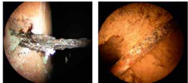
Abbildung 11: Links im Bild ist ein Drahtanker in der Luftschicht sichtbar, der im Bereich des Übergangs in die Verblendschale starke Korrosion mit Blattrostbildung aufweist. Auf der Aufnahme rechts ist ein Drahtanker im Bereich einer Schalenfuge mit geringen Korrosionserscheinungen sichtbar. Hier kann der Drahtanker freigelegt werden und über eine optische Begutachtung und ggf. einen Zugversuch weiter überprüft werden.
