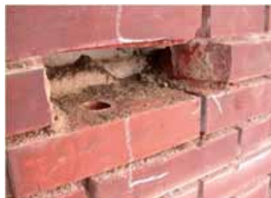
Abbildung 5: In der Praxis anzutreffende Mauerwerksöffnung zur Überprüfung von Verblend- zu Tragschale
