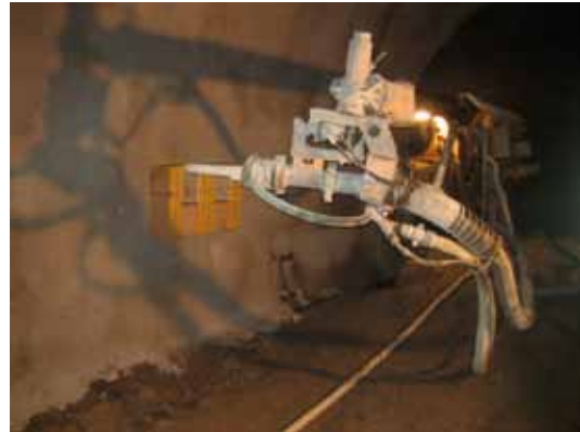
Abb. 2a: Spritzmanipulator für das mechanisierte Applizieren von Spritzbeton
