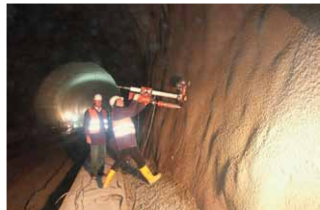
Abb. 2b: Kernbohrung zur Entnahme von Spritzbetonproben
