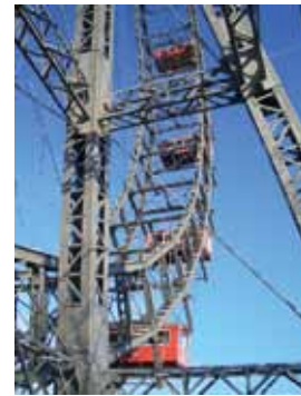
Wiener Riesenrad – Prüfungen der Seile und der Hauptachse
