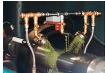
Besspülung eines Bauteiles
