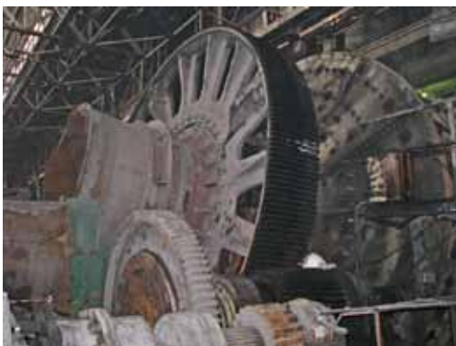
Wo nahm der Schaden seinen Ausgang?
