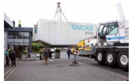
Das Unterteil des Maschinenhauses am Haken Fotos: Marco Stepniak
