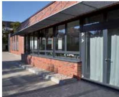
Das DGZfP-Ausbildungszentrum Wittenberge nach dem Umbau
