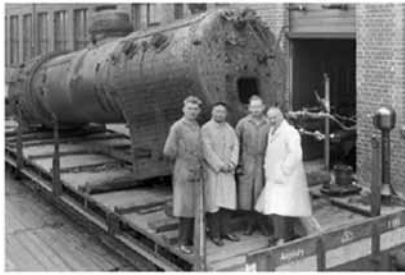
Röntgenprüfung einer Dampflokomotiv-Feuerbüchse mit den Herren Carl Kantner, Adolf Herr, Walter Grimm und Friedrich Wulff im Jahre 1931
