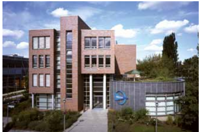
Das Ausbildungszentrum der DGZfP in Berlin-Adlershof
