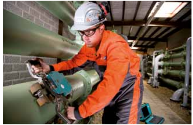
Abb. 6: SLOFEC™-System im Einsatz (Prüfbereich 02:00 Uhr-Pos.)
