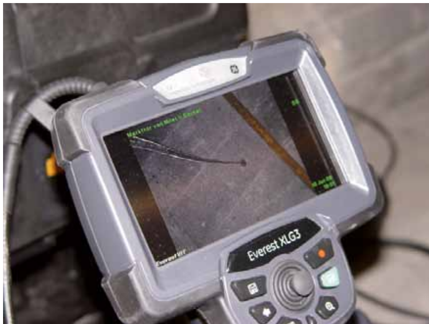
Invertierte Ansicht auf die Deckenkonstruktion
