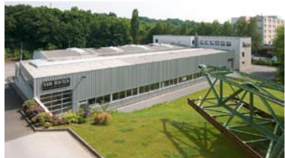
KARL DEUTSCH – Werk 2 mit Schwebbahn
