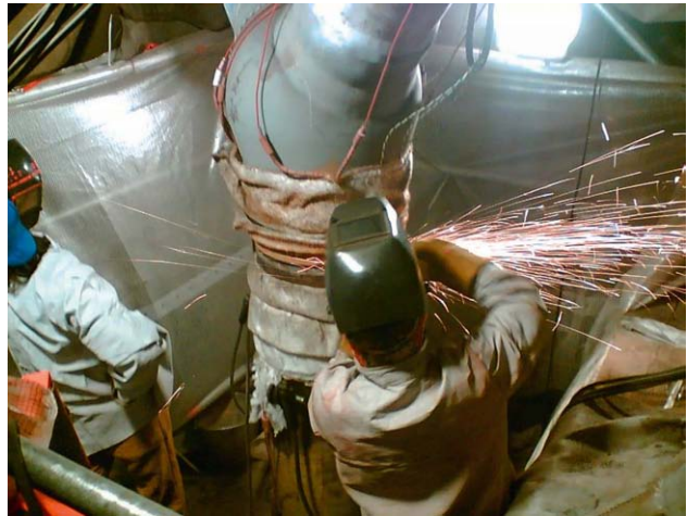
Schweißarbeiten am Kugelformstück der Leitungen ¼-Last auf ½-Last
