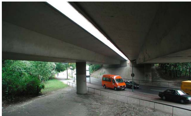
Abb. 12: Prüfbjekt. Hohlkastenbrücke in Berlin.
