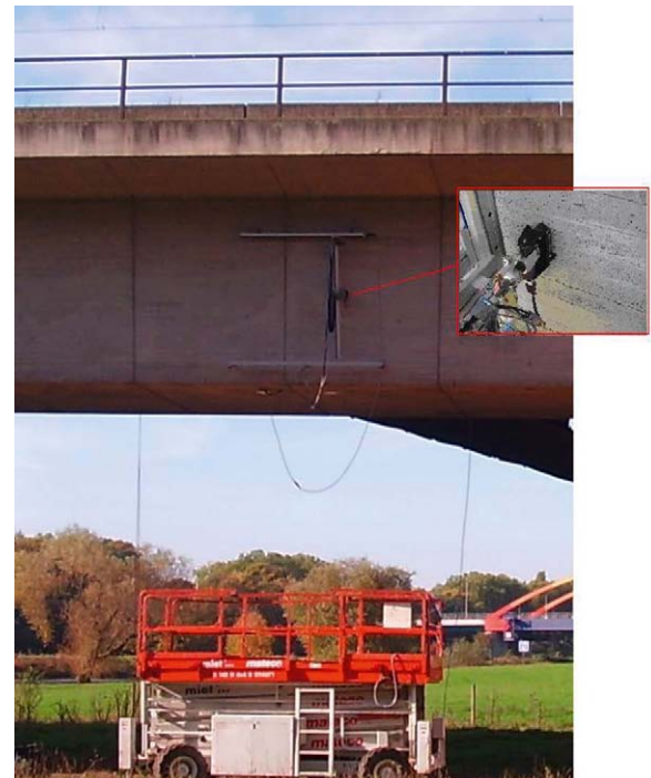
Abb. 6: Experimenteller Aufbau bei Impact-Echo-Messungen an einem realen Brückentragwerk in vorgespannter Hohlkastenbauweise. a) Anregung von der Außenseite
