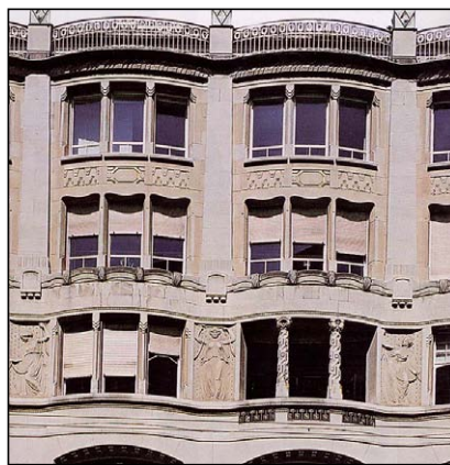
Jugendstil-Fassade am Haus Oceanic
