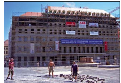
Der Betonskelettbau-Rohbau mit Ortbeton-auskleidungen
