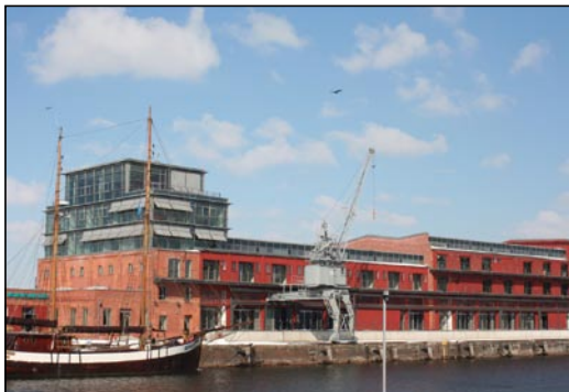
Der Technologiepark Media Docks entstand aus dem denkmalgeschützten historischen Lagerhaus im Lübecker Hafen. Hier fand die Preisverleihung statt
