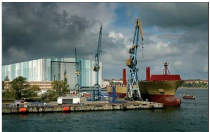
Das erste überdachte Dock Deutschlands steht in Wismar
