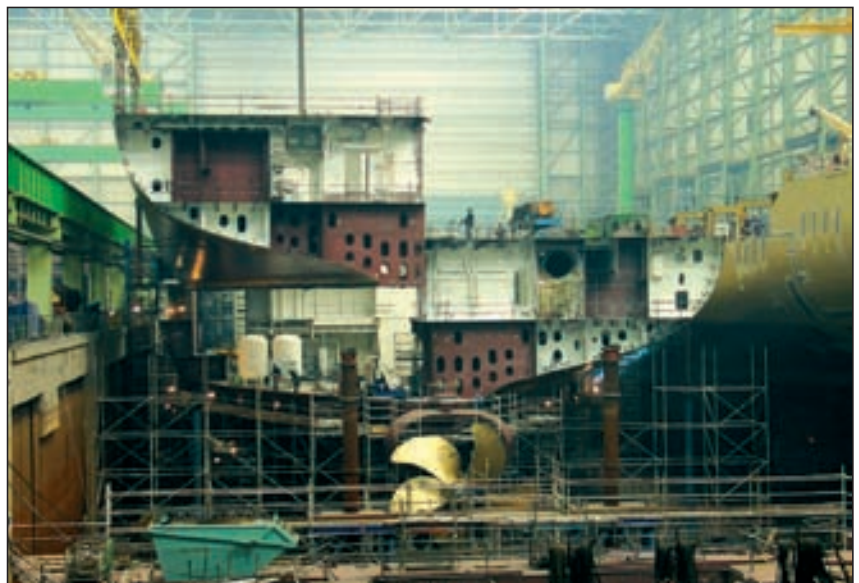
Im Dock werden die Segmente zusammengesetzt und verschweißt
