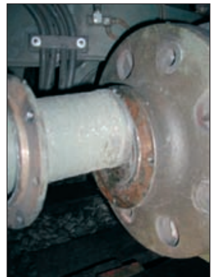
Radsatzwellenbruch im Januar 2001. Die Ursache konnte nicht ermittelt werden, da die Bruchflächen fast vollständig zerstört waren. Der Bruch ist nicht von der Prüfbohrung ausgegangen.
