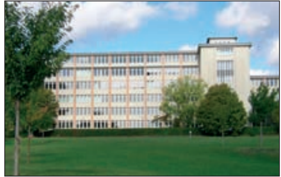
Das Airportcenter Dresden
