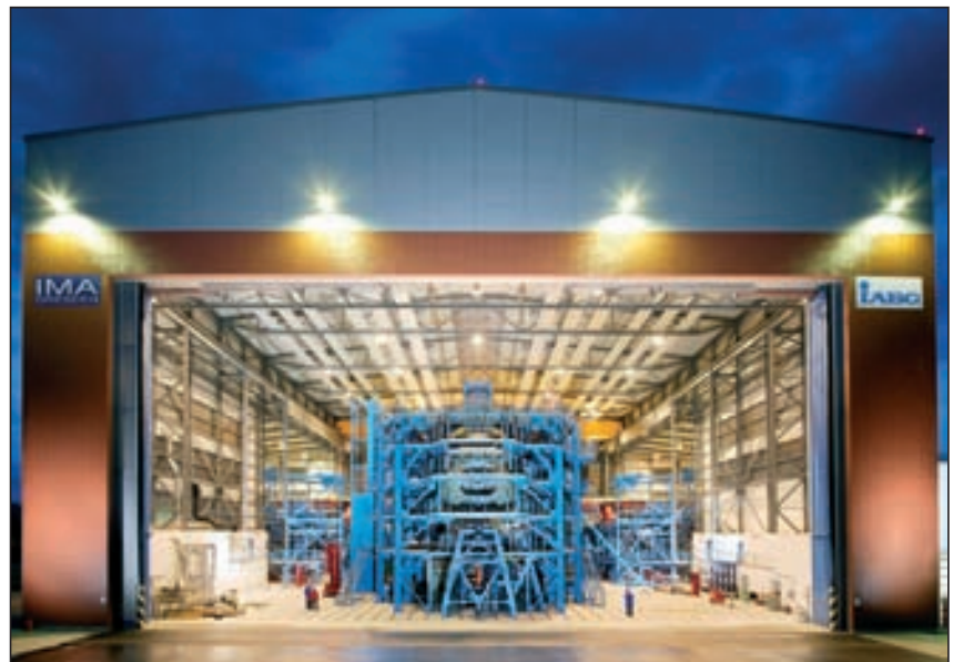
Versuchshalle für den A380 Ermüdungsversuch in Dresden
