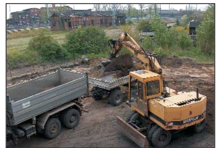
Stadium 2: Baubeginn im Juni 2003
