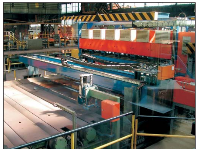
Eine 400-kanalige Anlage für die Grobblechprüfung, die inzwischen bei Mannesmann in Mühlheim betrieben wird
