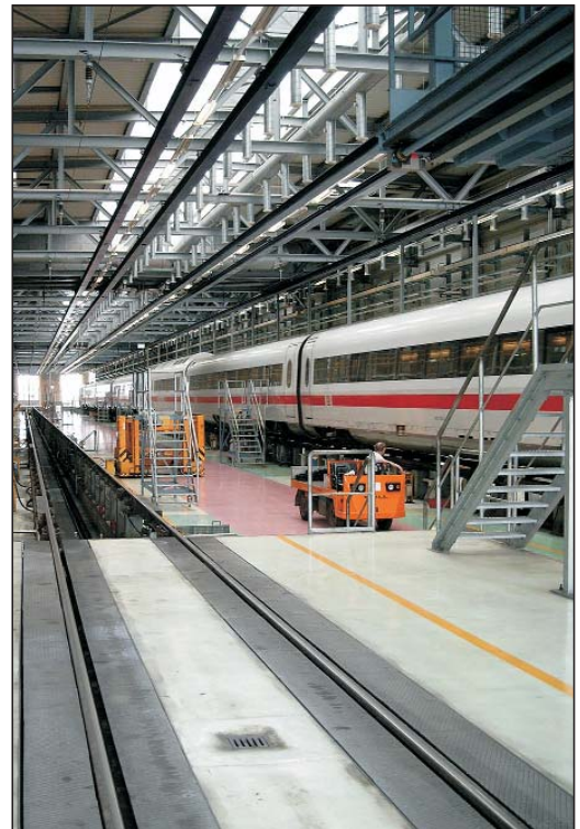
Die fünf aufgeständerten Gleise in der Triebzughalle ermöglichen das Arbeiten in drei Ebenen: Unterbau, Fahrgastraum und Dachbereich
