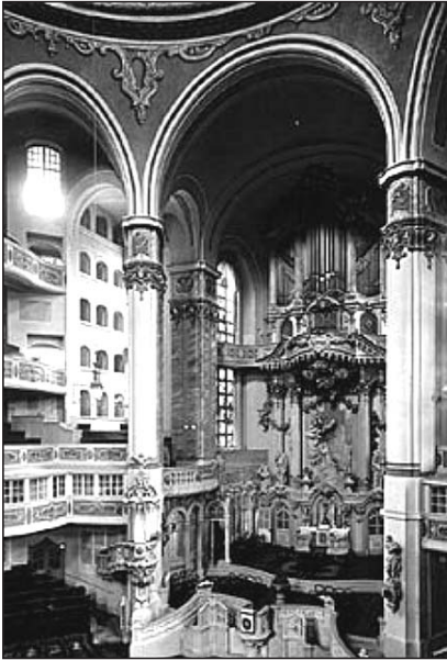
Der barocke Innenraum mit seinen fünf halbkreisförmig angeordneten Emporen ist von beeindruckender architektonischer Geschlossenheit und Schönheit zugleich
