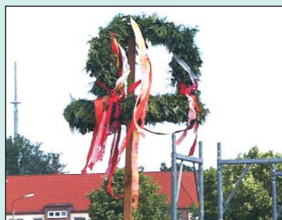
Der Richtkranz wurde aufgezogen ...
