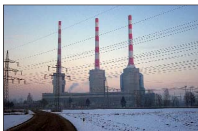
Das Kraftwerk Irsching
