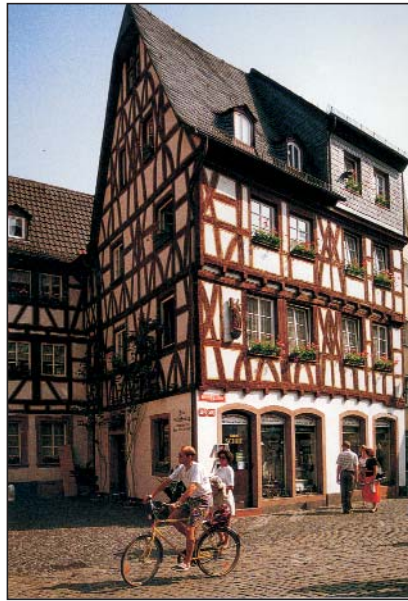
Das Fachwerkhause „Zum Aschaffenberg“ steht am Kirschgarten und stammt aus der zweiten Hälfte des 15. Jahrhunderts
