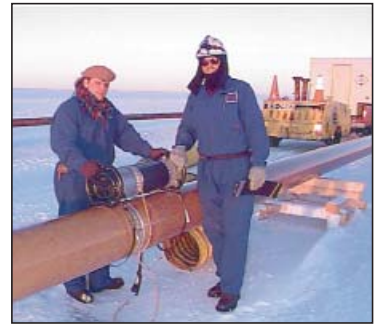
Auch unter extremen klimatischen Verhältnissen, wie hier beim Pipeline-Bau in Alaska, werden Schweißnähte mit portablen Röntgengeräten geprüft
