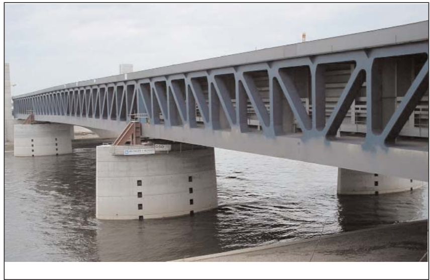
Die Kanalbrücke zum Zeitpunkt der AK-Exkursion
