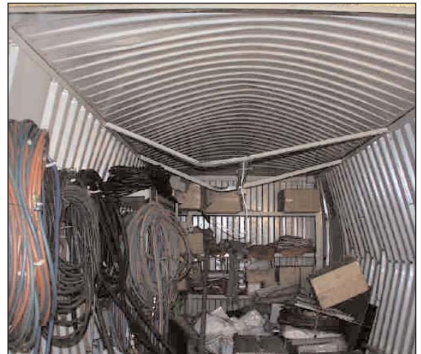
Innenansicht des verformten Containers nach der Verpuffung (Container ursprünglich rechteckig)
