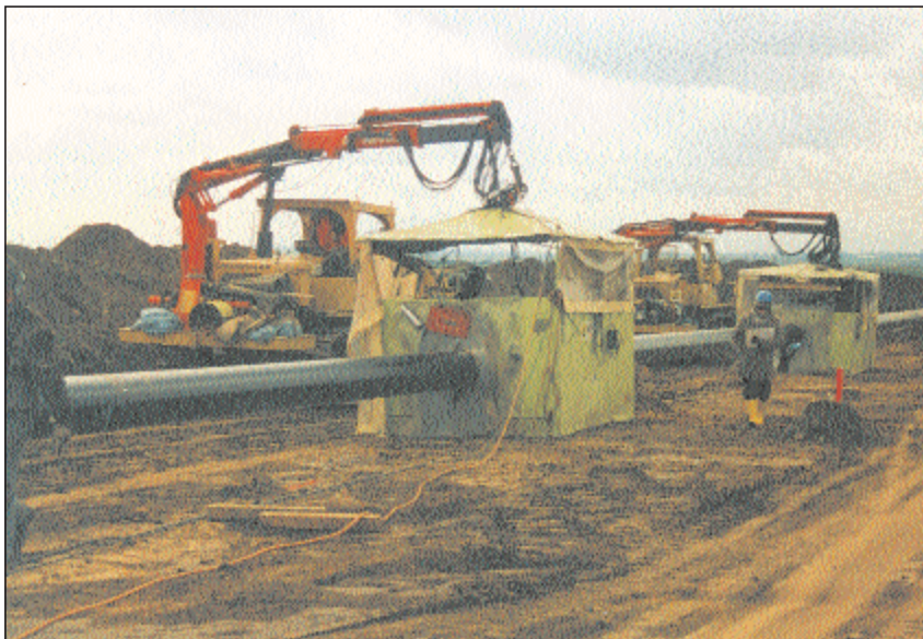
Prüfung von Schweißnähten an Pipelinerohren
