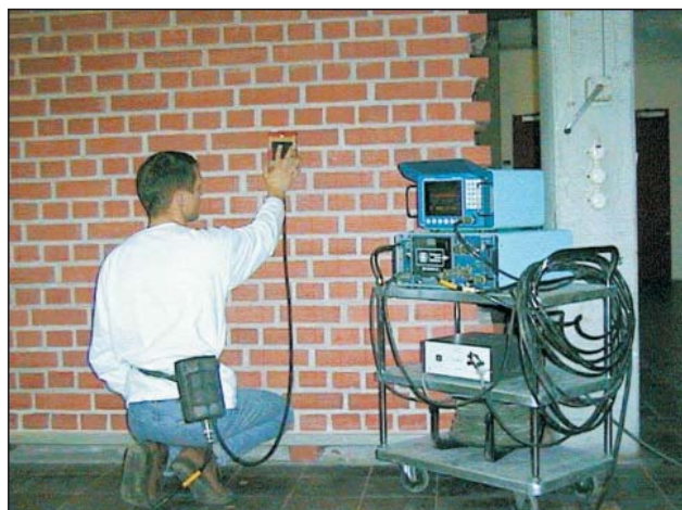
Abbildung 3: Radarmessungen mit einer 1,5 GHz Antenne an Mauerwerk
