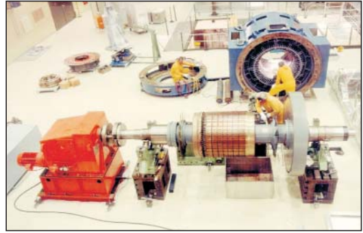
Abbildung 3: Wicklungsreparatur an HKMP-Motoren (8,3 MWe)
