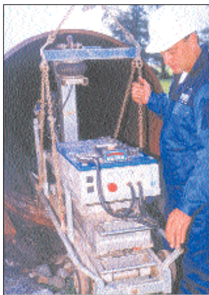
Zentimeter um Zentimeter werden ca. 18 km Schweissnaht geprüft
