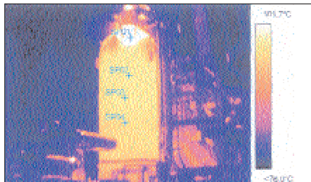
Bild 1: Thermographie-Bild eines Reaktors
