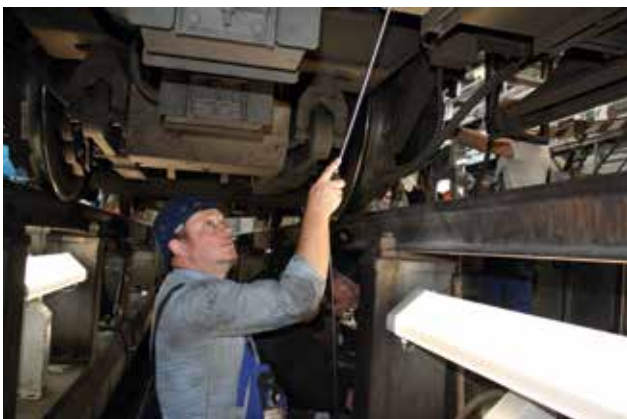
Sichtprüfung mit Videoendoskop am Unterboden des ICE
