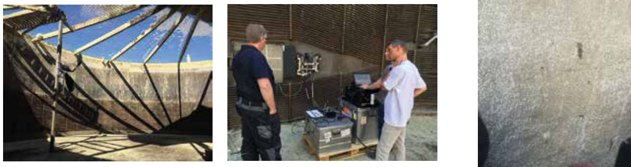
Abbildung 6: Links, Teilansicht des für Wartungszwecke geleerten und gereinigten Behälters. Mitte, Scanner während der Messung an der Behälterwand. Rechts, Messfläche mit sichtbaren Spuren, die der Laser durch den Abtrag einer geringen Materialmenge erzeugt hat.
