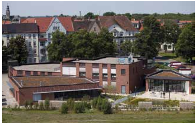
Das DGZfP-Ausbildungszentrum Wittenberge liegt nur wenige Schritte vom Bahnhof entfernt
