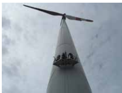
Inspektionslift mit Besatzung bei der koerzimetrischen Außenkontrolle einer Windenergieanlage
