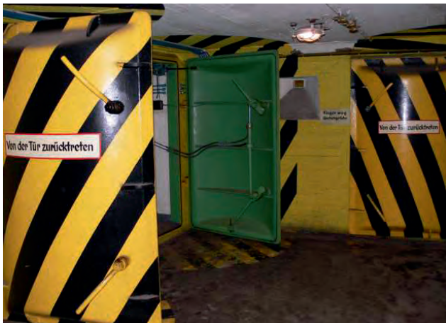
Die Bunkertüren mit speziellem Schließmechanismus
