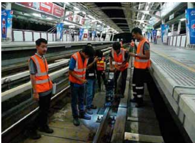
UT-Prüfung im Gleis bei der S-Bahn (BTS) in Bangkok
