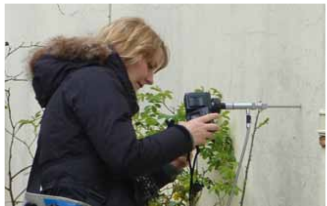
Saskia Frey bei der Bauwerksuntersuchung mit Endoskop
