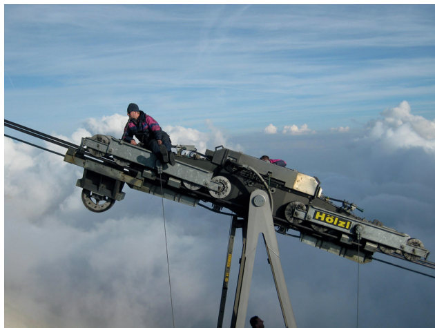
Abb.1: Konventionelle Seilprüfung in luftigen Höhen
