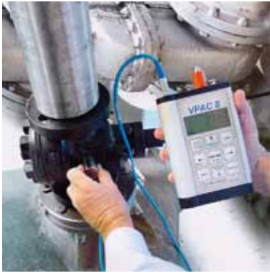
Abb. 1: Schallemissionsprüfung mittels VPAC II am eingebauten Ventil
