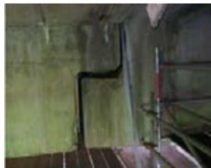
Abb. 5: Außenseite des Auflagers des Trägers
