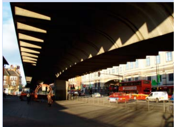
Fachbeitrag zum Thema: Einsatz von Schallemission für fortgeschrittene Strukturüberwachung an Brückenbauten
