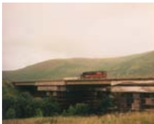
Abb. 4: Borrowbeck Bridge mit Gerüsten an Hammerkopf-Pfeilern und Auflagern
