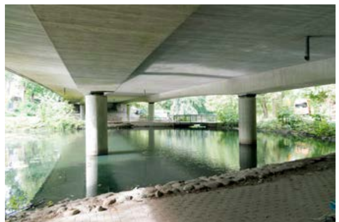
Abbildung 3: Die untersuchte Spannbetonbrücke [17]
