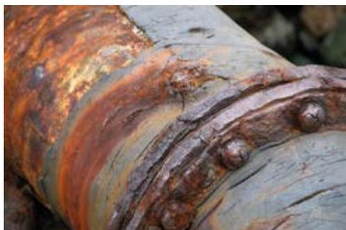
Abbildung 1: Spannungsrisskorrosion [Bild: pipeline-journal.net]
