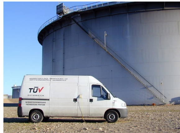
Abb. 5: Lagertank in der petrochemischen Industrie
