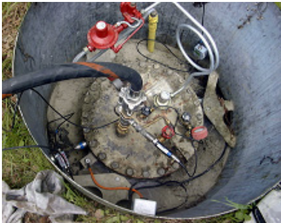
Abb. 14: Flüssiggaslagerbehälter oberirdisch aufgestellt oder eingegraben
