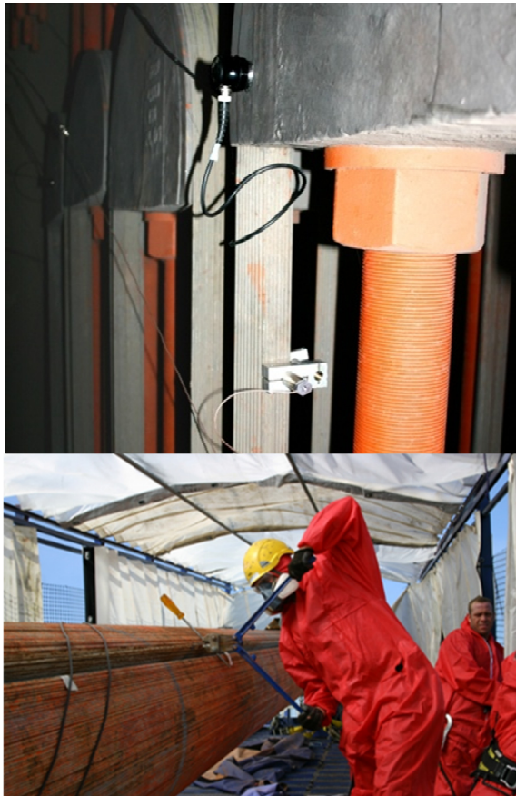
Abb. 24: oben: Mit piezoelektrischem Schallemissionssensor instrumentiertes Kabel, unten: Erzeugung von künstlichen Kabelbrüchen.
