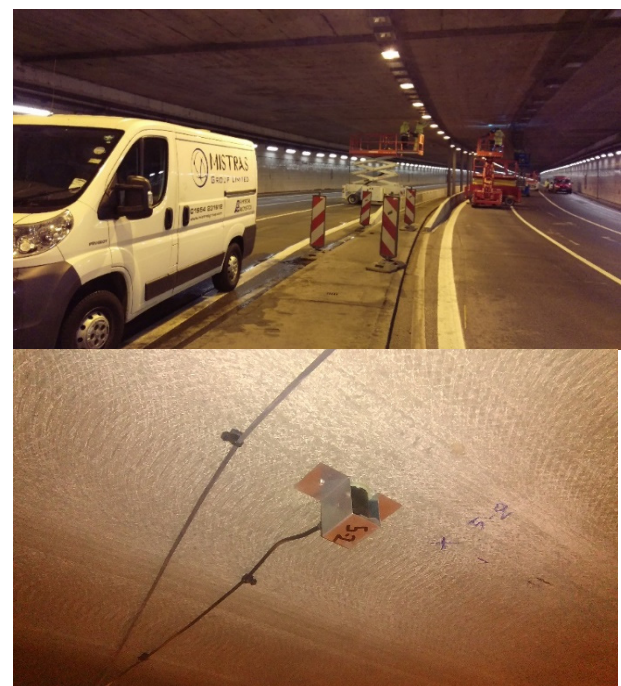
Abb. 19: Installation von Sensoren und Kabelverlegung mit Hilfe von Hubsteigern (links) und Bild eines angekoppelten Schallemissionssensors an der Tunneldecke (rechts)
