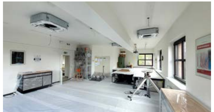
Baustellen-Charme zur Einrichtung der Klimanlage im Dortmunder Ausbildungszentrum
