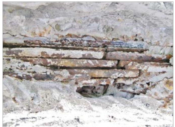
Abbildung 1: Beispiel eines Spannstahlbruchs infolge Spannungsrisskorrosion, der mit der magnetischen Streufeldmessung gefunden wurde
