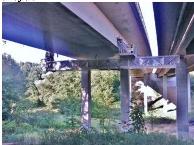
Abbildung 3: Brückenuntersuchung mit der magnetischen Streufeldmessung
