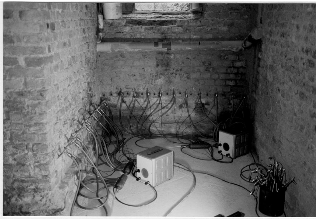
Abbildung 2: Thermisch-konvektive Vortrocknung der vorgesehenen Injektionsebene mit Heizpackern.
