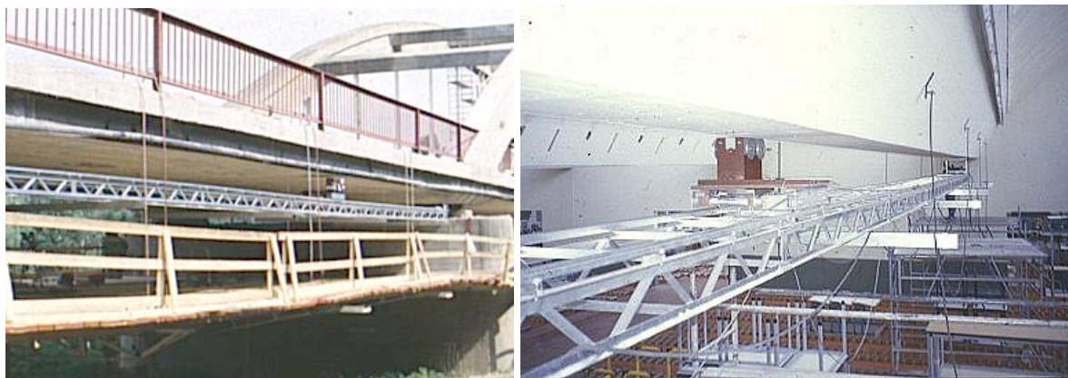
Abb. 9 Das Remanenzmagnetismus-Verfahren im Praxiseinsatz. Links: Überprüfung einer Spannbetonbrücke. Rechts: Überprüfung eines Spannbetonbinders.
