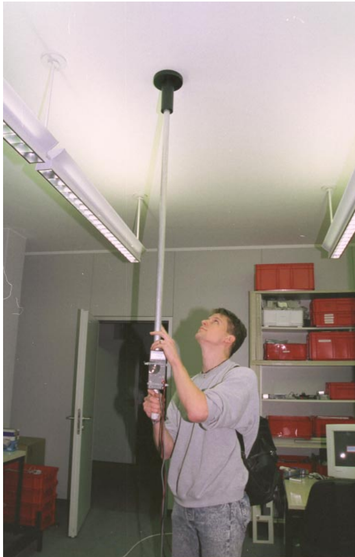
Abb. 4: Ortung von Bereichen, in denen der Gipsputz keinen Verbund mit dem Untergrund hat.
