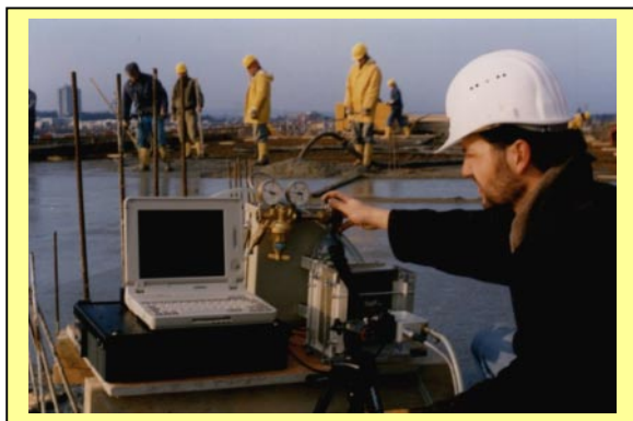
Beispiel für den Einsatz des Prototyps bei der Qualitätssicherung im Baubetrieb (Erhärtungskontrolle Vorort).
