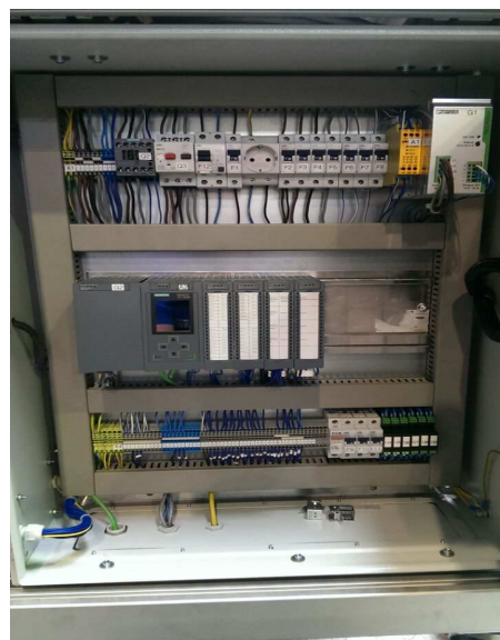
Abb. 4: verdrahteter Schaltschrank
